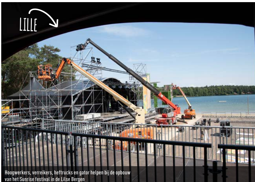
Ook bij het plaatsen van de zonnepanelen aan ons nieuw hoofdkwartier worden hoogwerkers ingezet.
